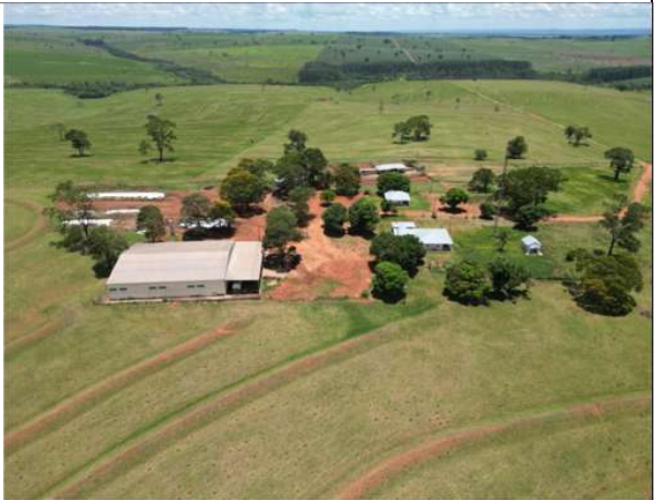
Figura 18. Vista do barracão
