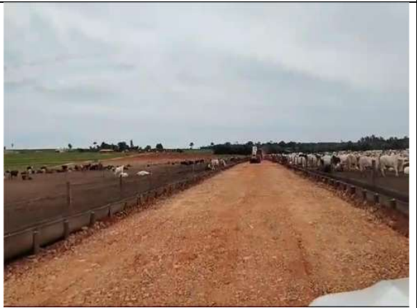
Figura 22. Pavimentação da estrada confinamento
