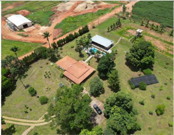
Figura 6. Vista do barracão
