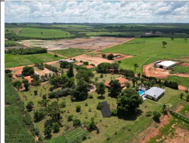
Figura 5. Vista da estrutura da sede e confinamento
