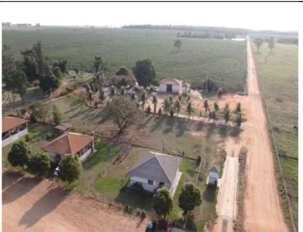
Figura 12. Vista da estrada e casas funcionários
