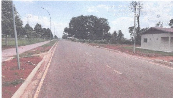
Figura 7-Vista da Via de Acesso ao Imóvel (Sentido centro da Cidade)
