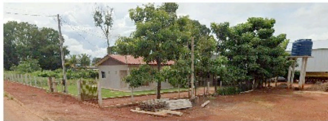
Figura 1- Vista Frontal do Imóvel
