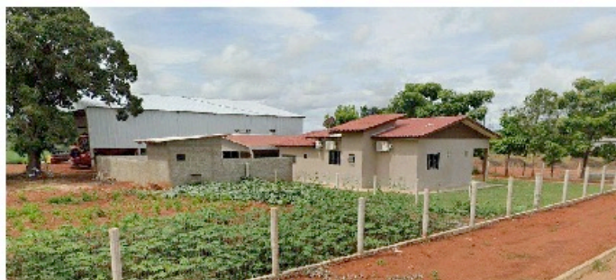
Figura 2- Vista Lateral do Imóvel
