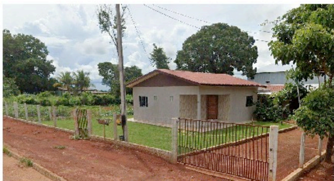
Figura 4-Vista Frontal do Imóvel
