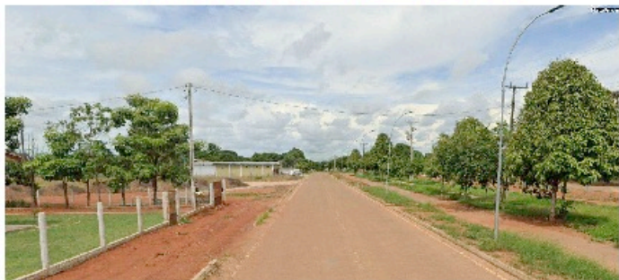
Figura 8-Vista da Via de Acesso ao Imóvel (Sentido Bairro Progresso)
