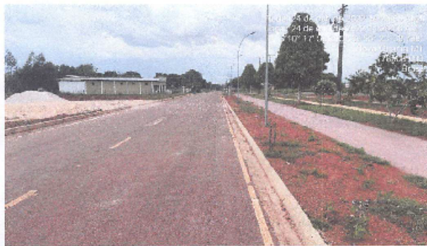
Figura 8-Vista da Via de Acesso ao Imóvel (Sentido Bairro Progresso)
