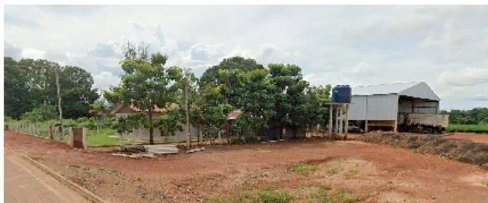
Figura 5- Vista do Barracão de Máquinas
